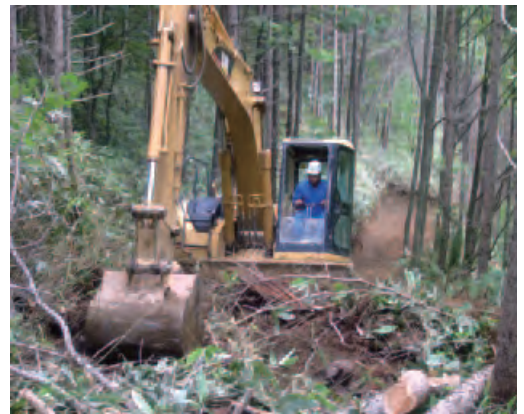
森林作業道の作設の様子
