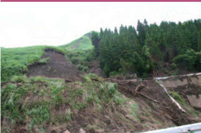
草地で発生した浅い崩壊は1か所あたりの流出土砂量は少ないが、発生密度が高かったために土量が多くなり道路が被災し寸断
