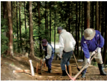
ハイキングコースの傷んだ階段の補修作業
