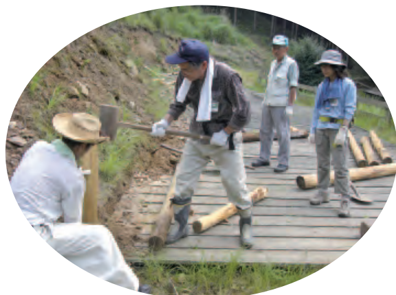
老朽化したキャンプ場土手の修理作業
