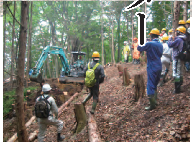
作業道作設実習
