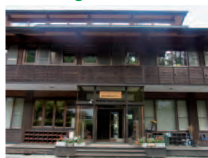
① 事務所棟入口
