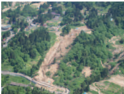
被災状況(平成16年10月撮影)
