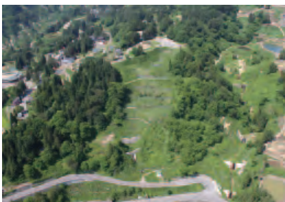
復旧状況(平成24年6月撮影)
