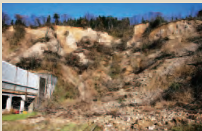
小千谷市浦ノ山地区の被災直後の様子
