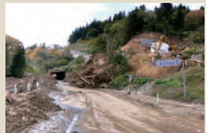
被災直後の国道等の様子(小千谷市呼坂地区)
