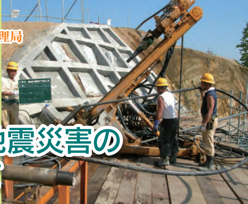
▲アンカー工の様子(小千谷市小栗山) 不動地盤まで挿入した鋼材で地すべりを固定
