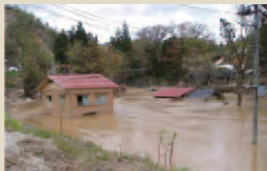
土砂などが河川の水の流れをせき止めたため水没した集落(旧山古志村 木籠地区)
