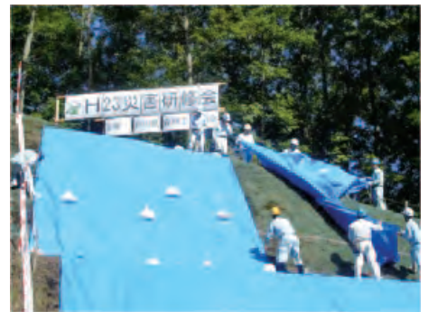
山地防災ヘルパー研修会での応急工事実技研修
