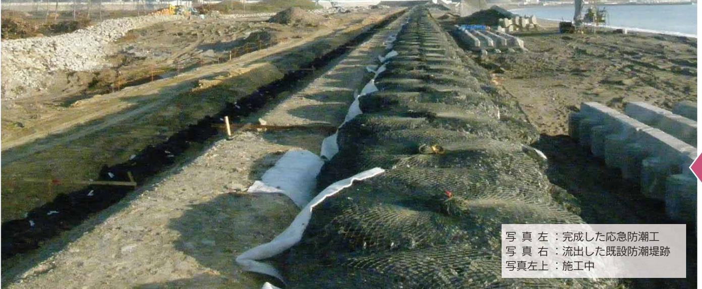
写真左：完成した応急防潮工事
