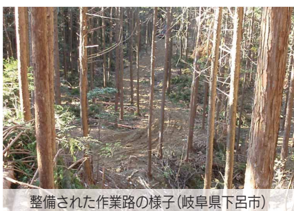
丈夫で簡易な作業路の整備の様子(岐阜県下呂市)
