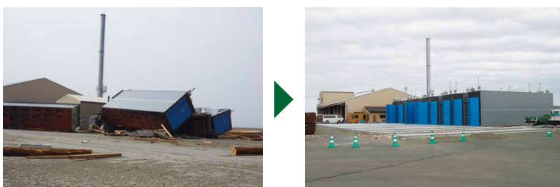
写真1 宮城県内の製材工場の乾燥施設の復旧状況
