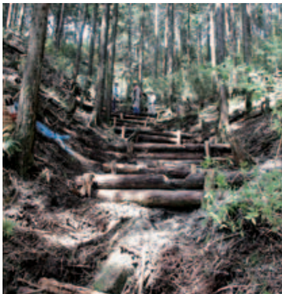
間伐と共に土留工を実施
