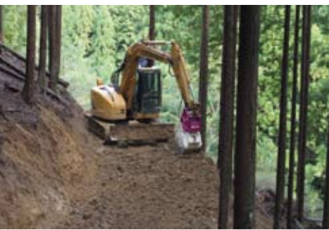
作業道の開設
