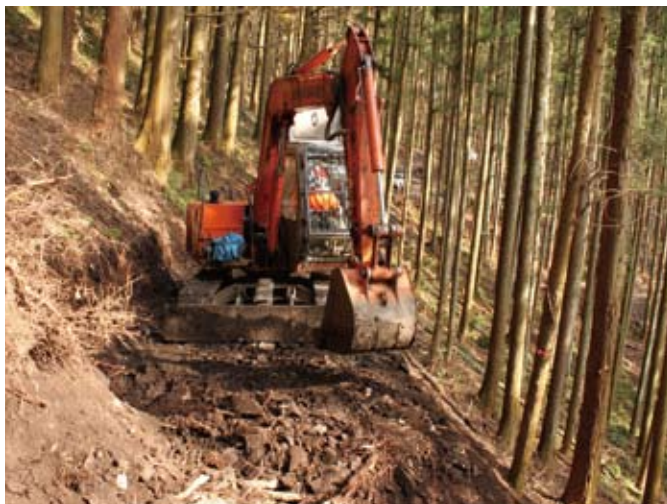
作業道の開設を行うバックホー
