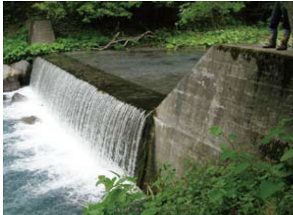
改良前の赤イ川治山ダム
