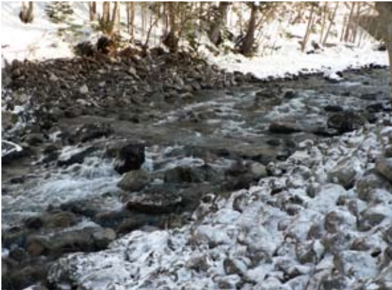
改良後の赤イ川治山ダム
