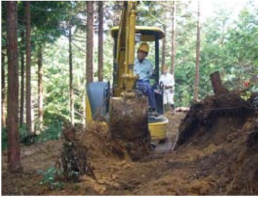
路床部分も一度切削して締め固める
