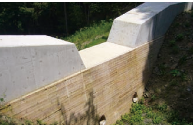
治山ダム用の木製残存型枠
