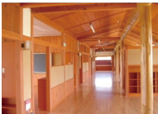
小学校の内装材に間伐材を利用
