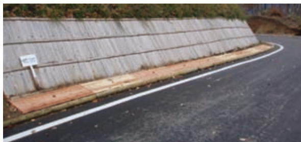
パネル法面工
