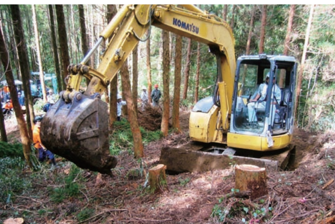
作業路の作設（大分県由布市 立石国有林）
