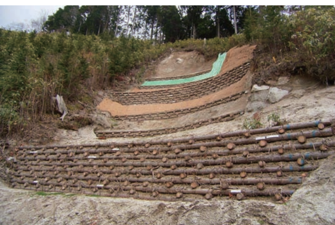
間伐材を使用した山腹工（岐阜県恵那市 上村恵那国有林）
