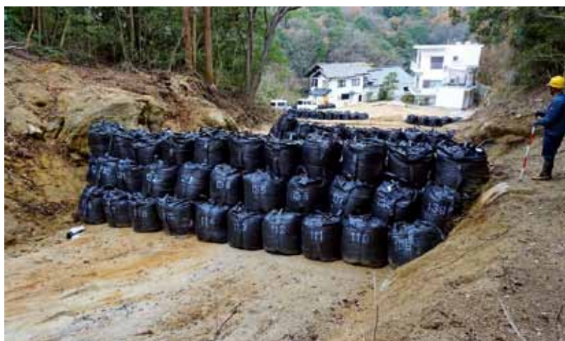
写真2 広島県における応急対策の状況
