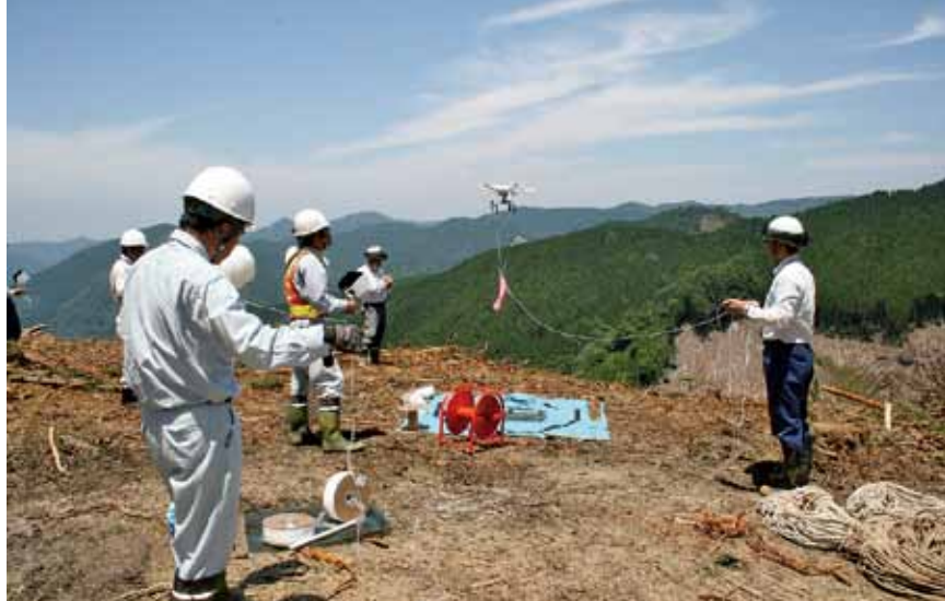
写真4 無人航空機を利用した架線設置省力化
