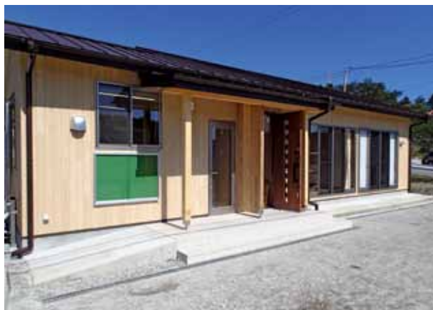
写真8 CLTを活用して修繕し、再開した関東森林管理局 磐城森林管理署 草野森林事務所
