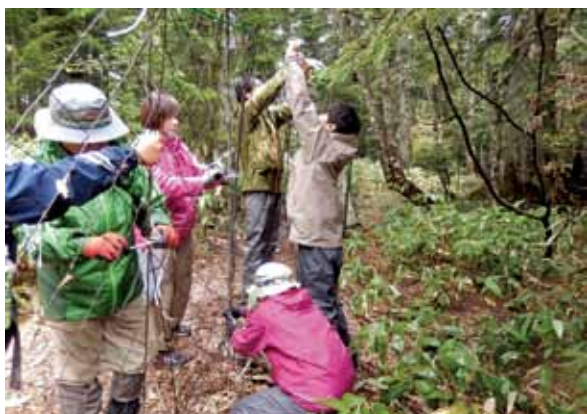
写真3 シカの侵入を防ぐ防護柵を設置する様子
