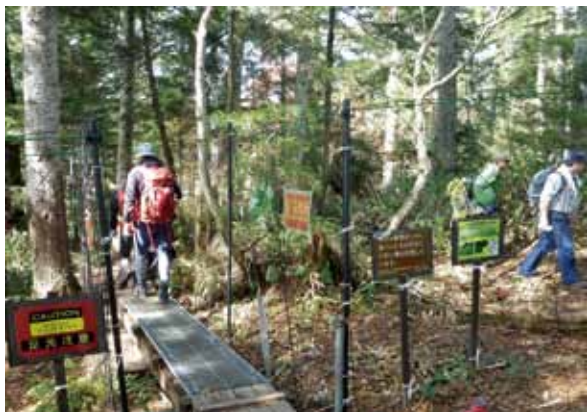
写真2 設置したグレーチング
