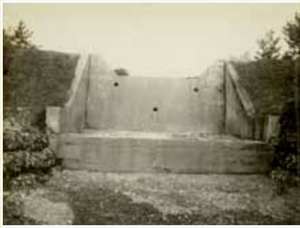
コンクリート放水路付堰堤の変遷 (1931)
