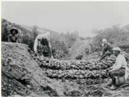
鉄線蛇籠堰堤の設置工事
