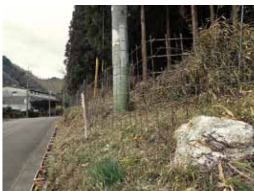
写真5 イノシシ移動防止柵の設置（古城山国有林）
