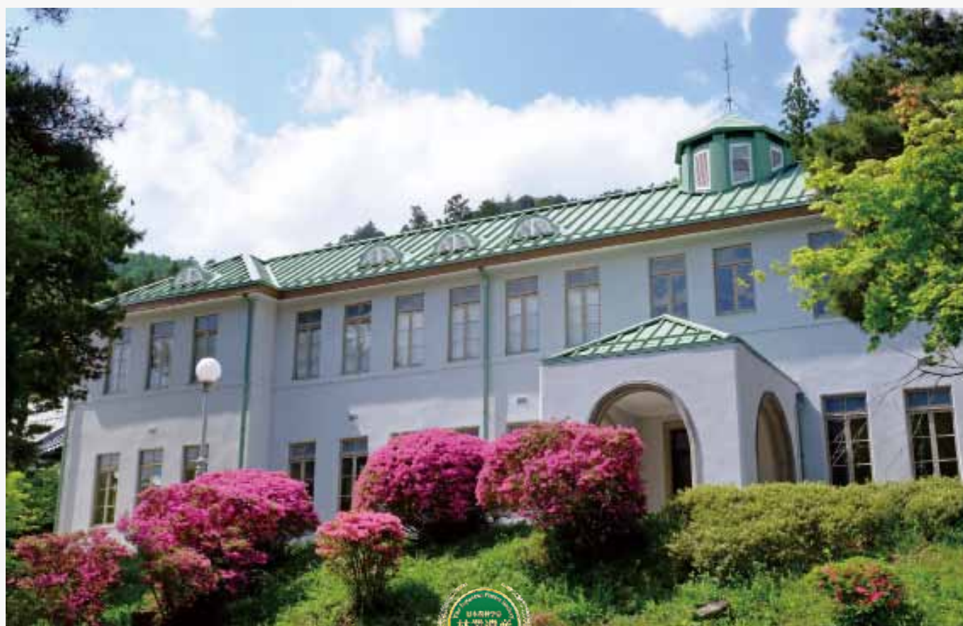
旧帝室林野局木曾支局庁舎（現御料館）
