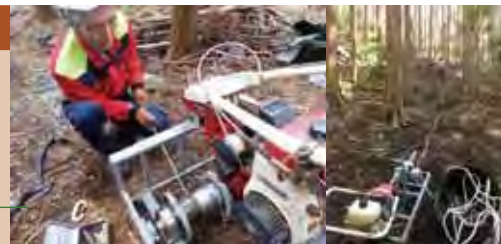
溝切り機等を改造したロープウインチ
