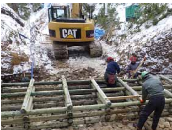
写真3 木材を利用した治山ダムを施工している様子 (北海道森林管理局)
