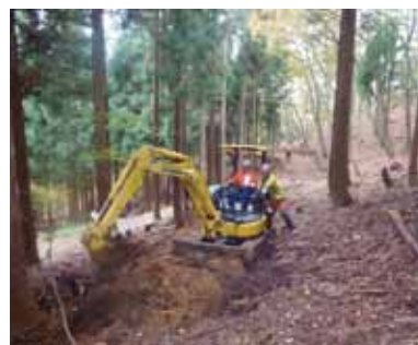
作業道敷設作業実習
