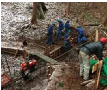
モノレールの設置作業
