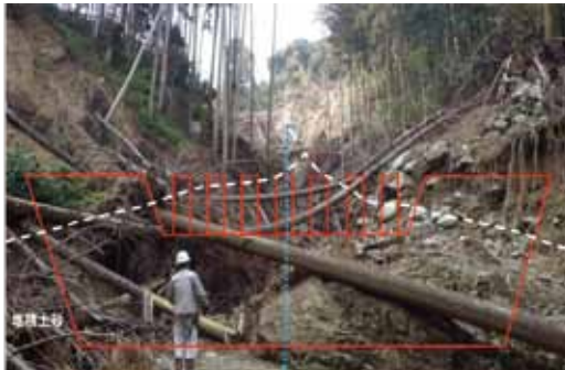
【主な対策①】流木捕捉式治山ダムの設置 溪床を安定させるとともに、流木を捕捉します。
