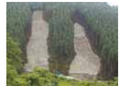
崩壊斜面の復旧状況 (大分県日田市)
