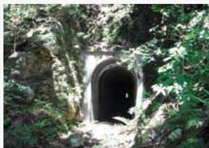
写真8 森林軌道のトンネル跡
