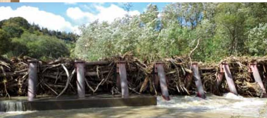
6 幌加内町でのスリットダムによる流木対策（北空知支署管内）
