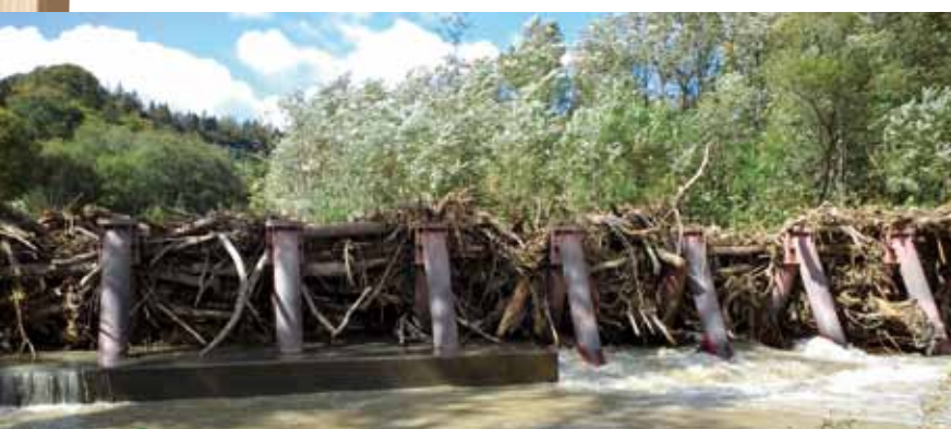
6 ほろかない 幌加内町でのスリットダムによる流木対策（北空知支署管内）
