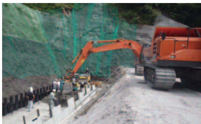
④ ソイルセメント工法（内部材投入の様子）
