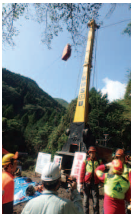
ピヒル研修所講師によるタワーヤーダ作業の現場指導
