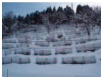
なだれ防止施設
