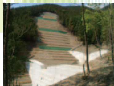
山腹工の脚部を固定する治山ダム
