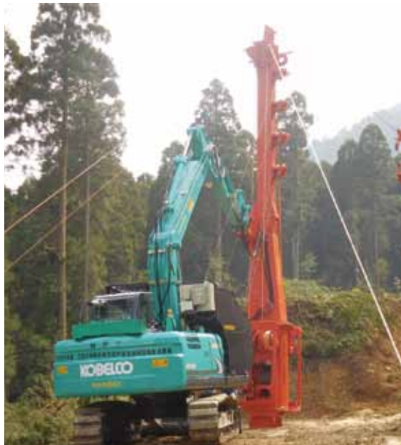
タワーヤーダ ：4つのドラムを備えることで、複雑な索張りへの対応が可能に。
