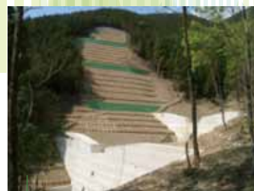
山腹工の脚部を固定する治山ダム
