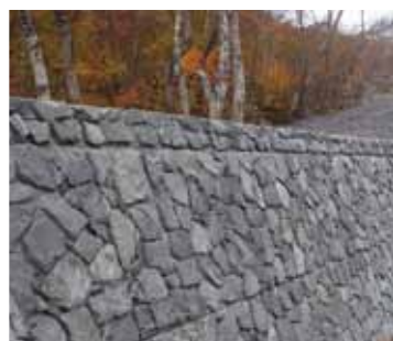
⑤ 天然石張型枠（石積模様）の施工状況
