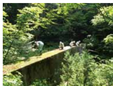
山地防災ヘルパーによる治山施 設の点検(石川県加賀市)
