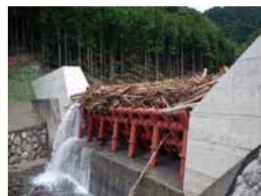
流木を捕捉するスリット式治山ダム
