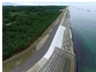
防潮堤(背後は海岸防災林)
