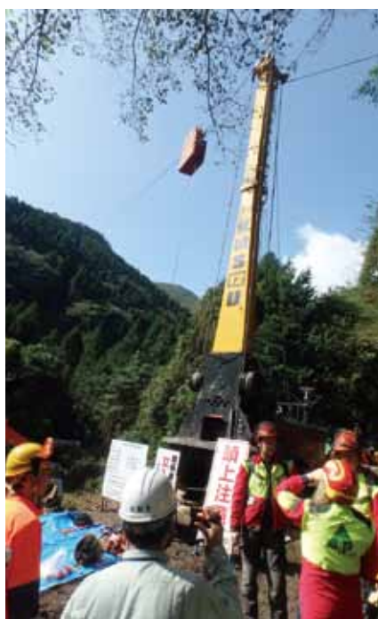
ビヒル研修所講師によるタワーヤーダ作業の現場指導
