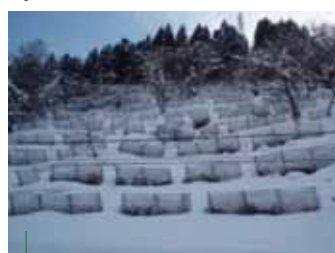
なだれ防止施設
