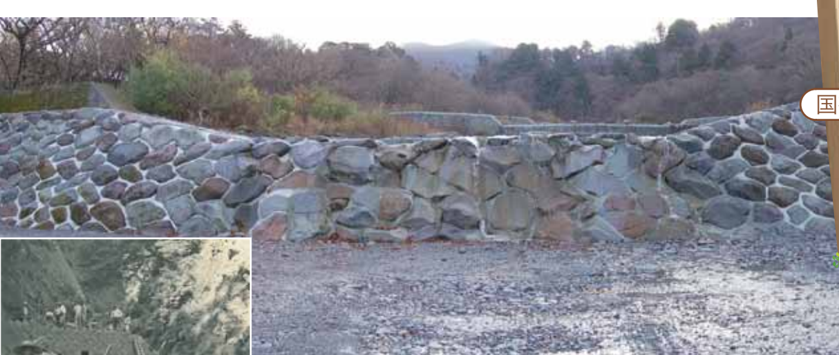
上：大正9年施工の大山（佐陀川）第11号堰堤（平成21年に補修済み） 左：ほとんどが人力施工による工事の様子（昭和初期、本谷奥）
