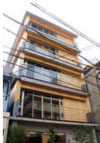
CLT利用事例 福祉施設（奈良県）5階建て
