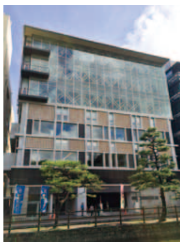
CLT利用事例 事務所（高知県）6階建て
