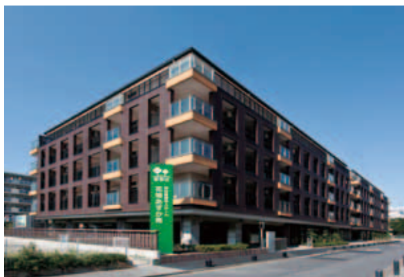
花畑あすか苑 (東京都足立区、5階建て、延床面積9,790㎡、2016年6月竣工)
