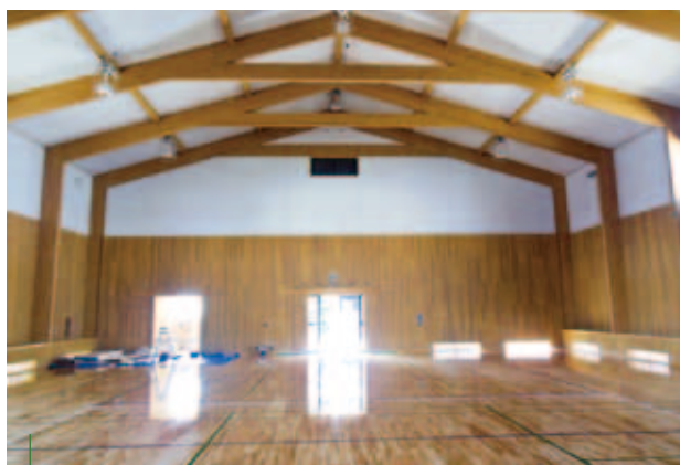
BPP材による高校武道場の施工例（熊本県八代市）
