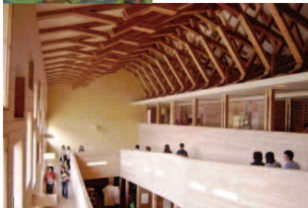
信州型接着重ね梁による施工例（熊本県和水町）
