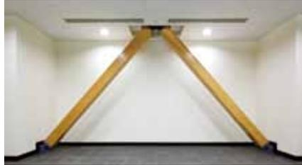
CLT、集成材、LVL等の高強度性や加工性、軽量可搬性を活かし、RC造等の大規模建築物の耐震補強を行う木質系耐震補強システム。
