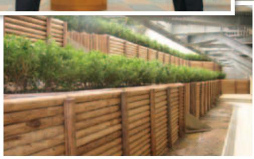
間伐材を利用した斜面防護と森の再生を実現する「全天候フォレストベンチ工法」を開発。
