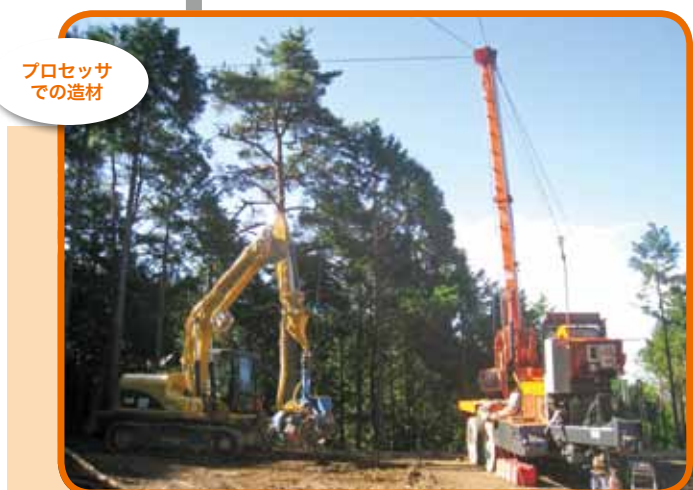
タワーヤード（中）や集材機（右）による架線集材ののち、土場でプロセッサ（左）による造材を行います。
