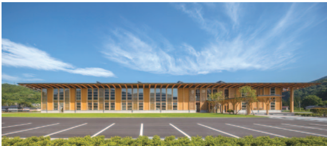
平成26年9月に開庁した住田町役場新庁舎
