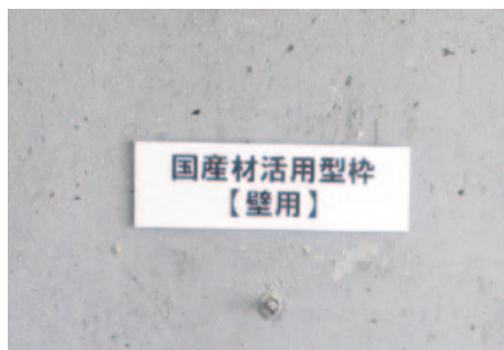
国産材型枠用合板による壁の仕上がり面
