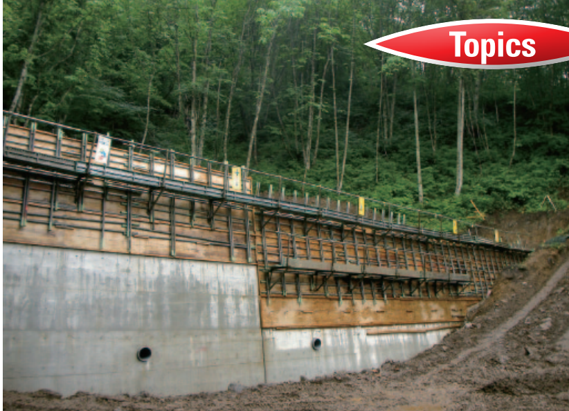
治山工事で使用中の間伐材等を利用した国産型枠用合板
