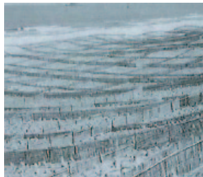
施工状況(昭和30年頃)
