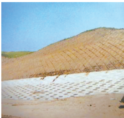
完成時の外観(平成7年)
