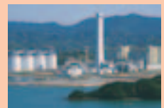
石炭火力発電所での混合利用
