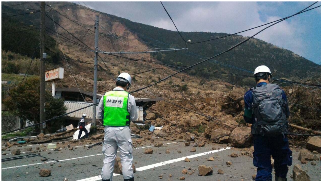
国道57号線から崩壊地上部の状況
