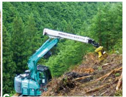
6 一貫作業システムの工程の一つである重機による地拵え (関東森林管理局)
