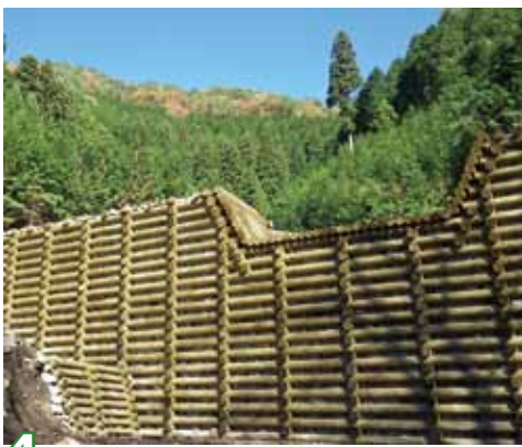
4 間伐材を使用した校倉式谷止工の全景（近畿中国森林管理局）
