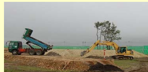
生育基盤の整備のための盛土工事
