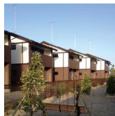
明神前地区 災害公営戸建住宅 明神前地区災害公営戸建住宅は第一号の災害公営住宅戸建てです。 戸建て住宅(平屋と二階建て)は家族向けとして施工されています。
