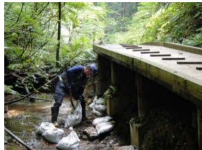
木道橋脚部の点検の様子
