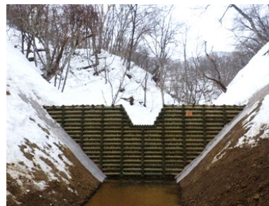
校倉式の治山ダムの全景
