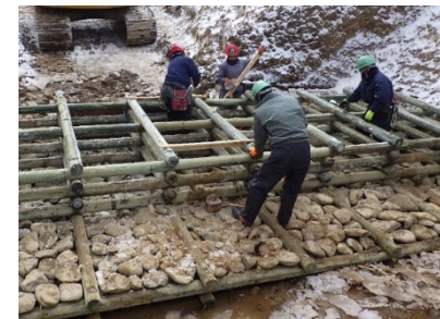
施工中の様子
