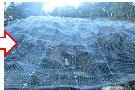
復旧完了の様子
