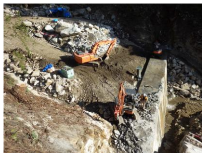
既存治山ダムの嵩上げ工事
