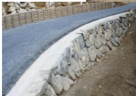
木柵工と、現地発生のかん石を活用した練石積
