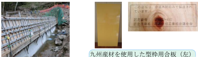
型枠用合板を活用した谷止工
