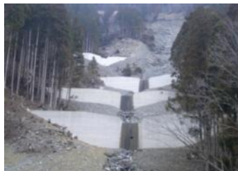
国有林内に設置した溪間工
