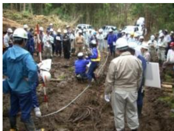
森林作業道作設の現地検討会
