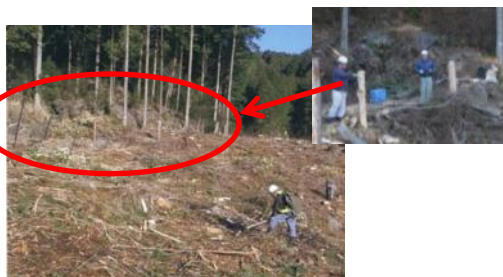
防鹿網の設置及び植栽の様子
