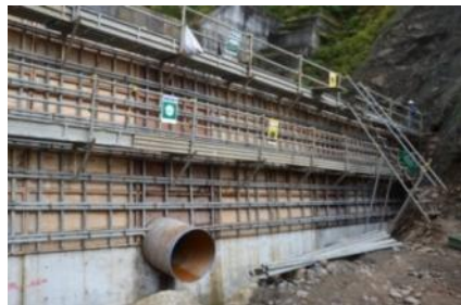
国産材型枠用合板の設置の様子
