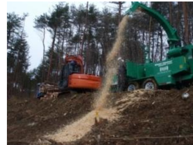
現地発生材のチップ化
