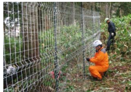
シカ侵入防止柵の設置
