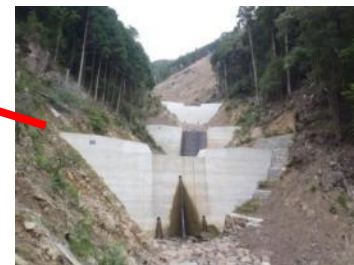
施工した溪間工
