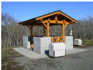
改修後の炊事場
