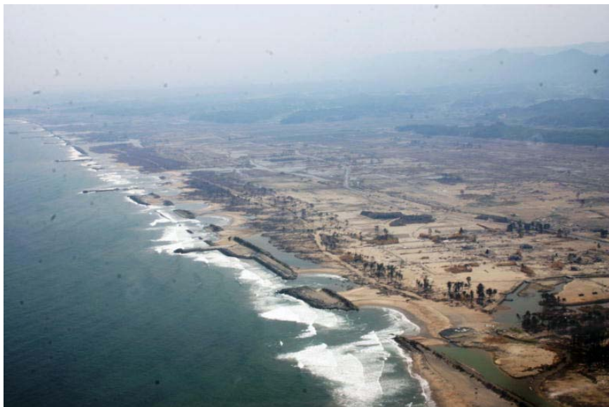
平成23年(2011年)東北地方太平洋沖地震により発生した 津波により被災した海岸防災林 (宮城県山元町、東北森林管理局管内)
