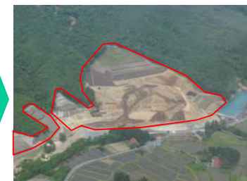
災害復旧工事施工中
